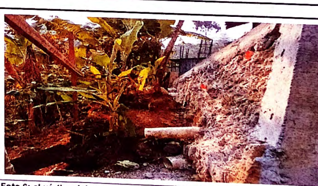
Foto 6: el vértice del muro perimetral también se encuentra completamente levantado la altura y el largo.
